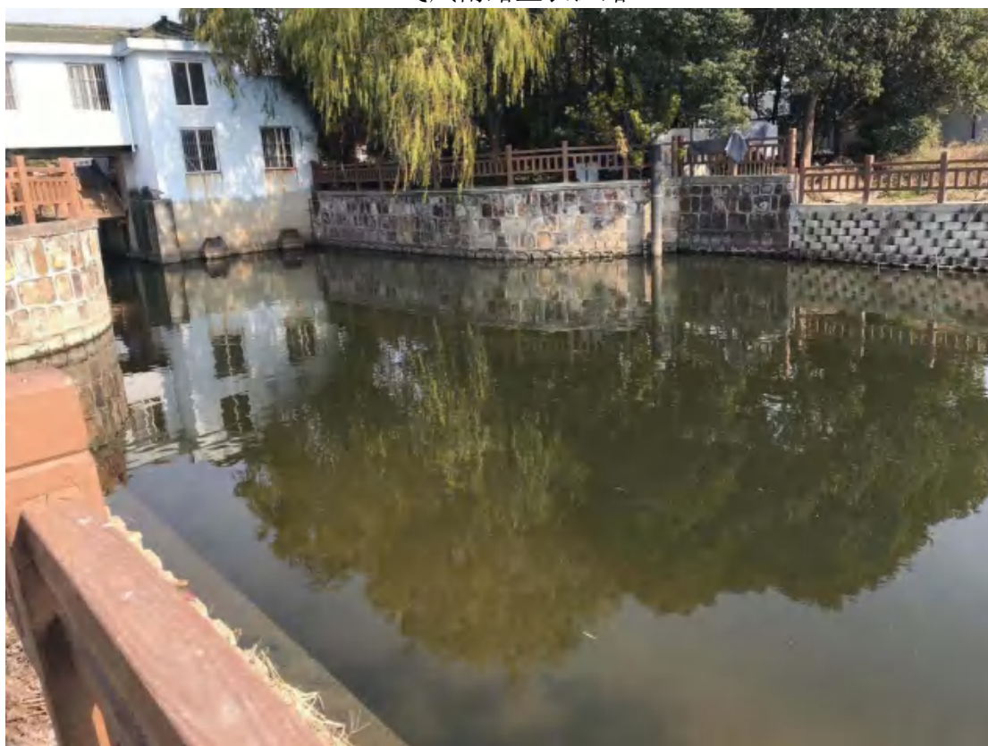
4. 长江路南闸站
