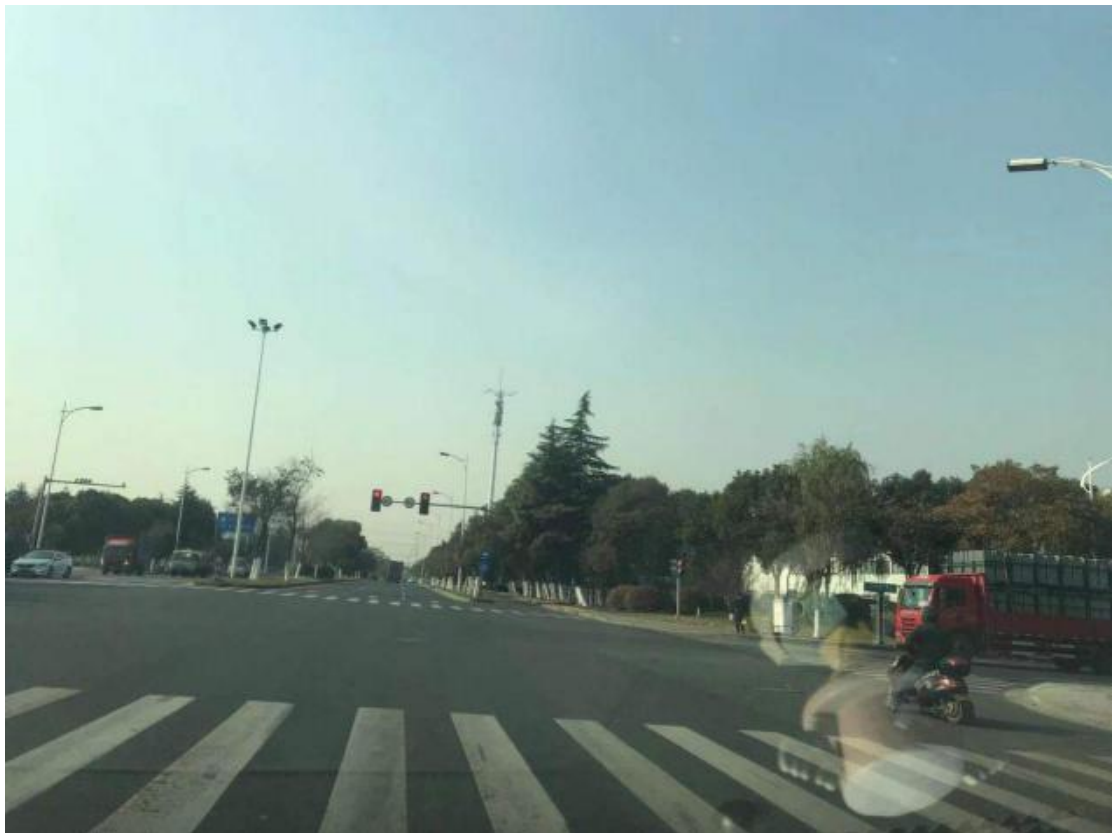
16. 锡梅路给水管道回填及道理修复
