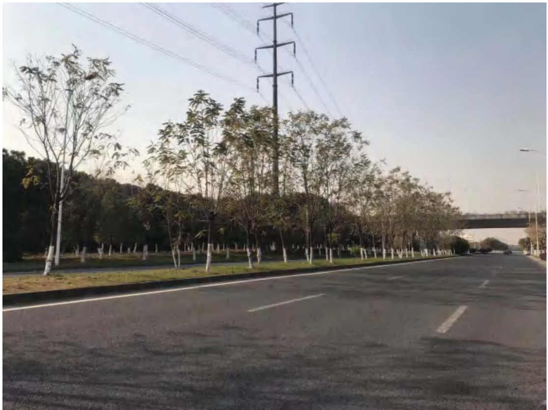
18. 锡梅路给水管道回填及道理修复
