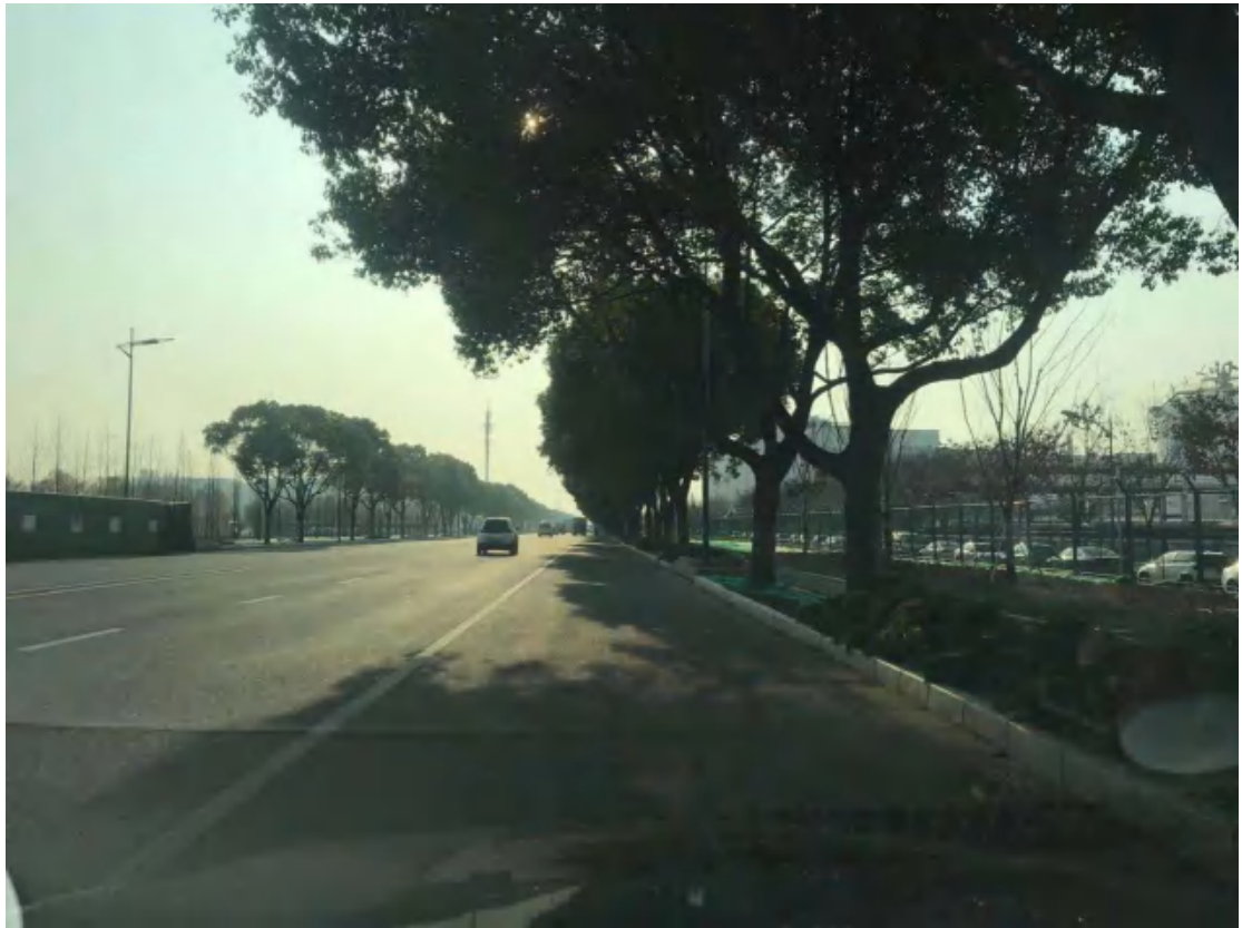
20. 新洲路给水管道回填及道理修复
