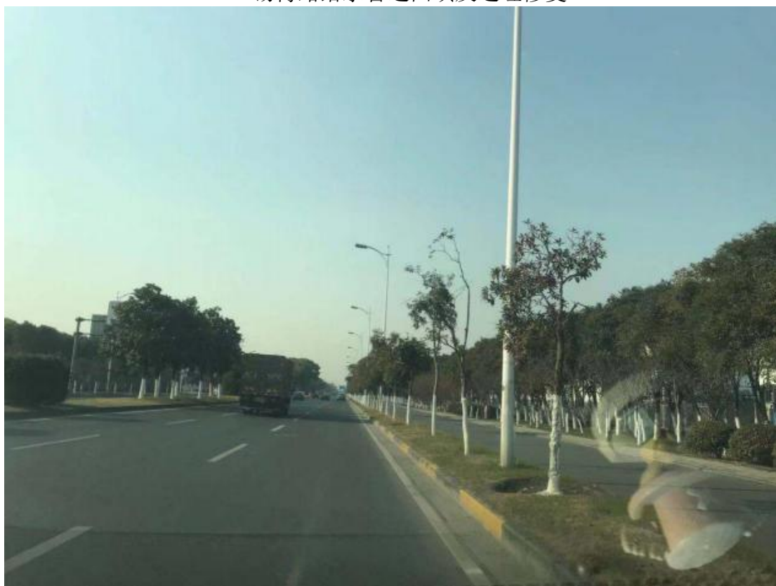
14. 锡梅路给水管道回填及道理修复
