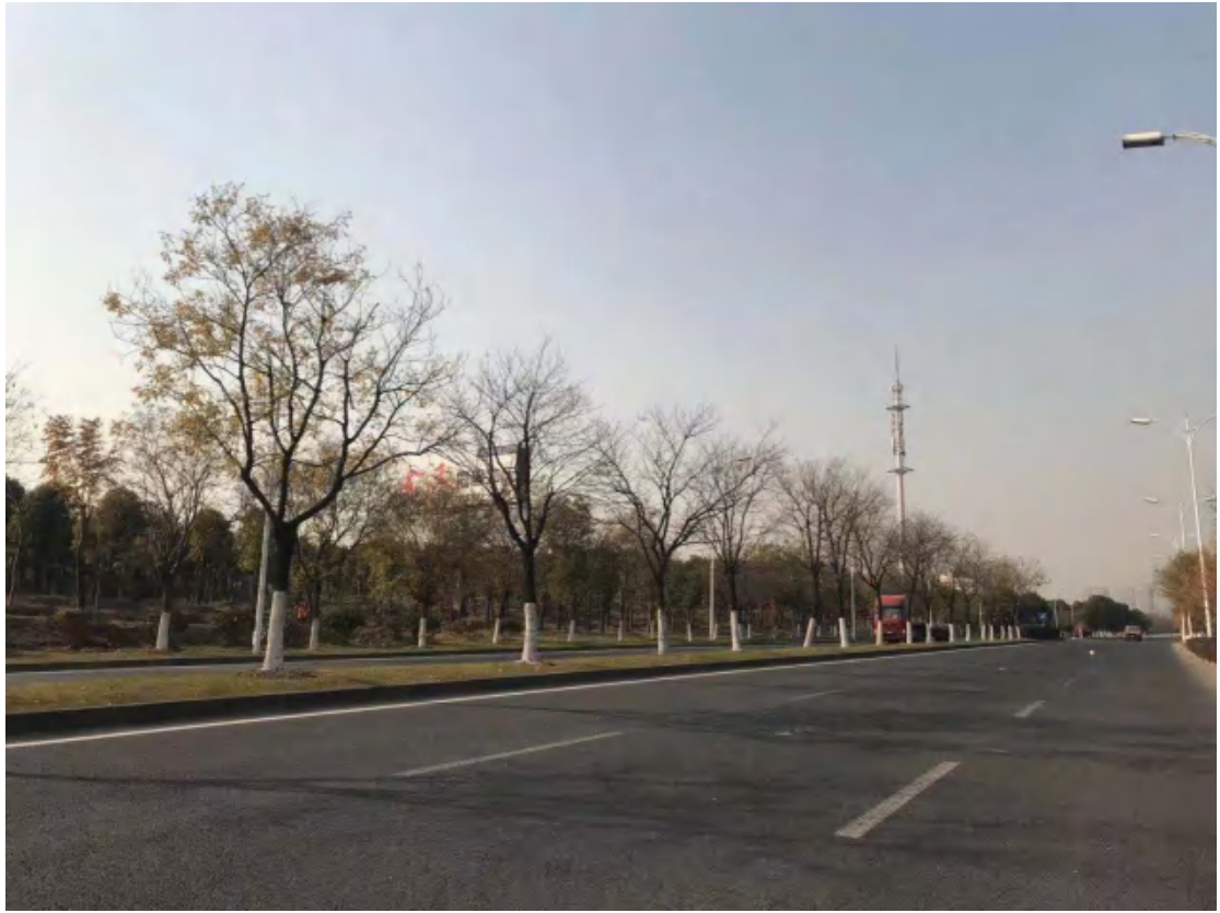
19. 锡梅路给水管道回填及道理修复
