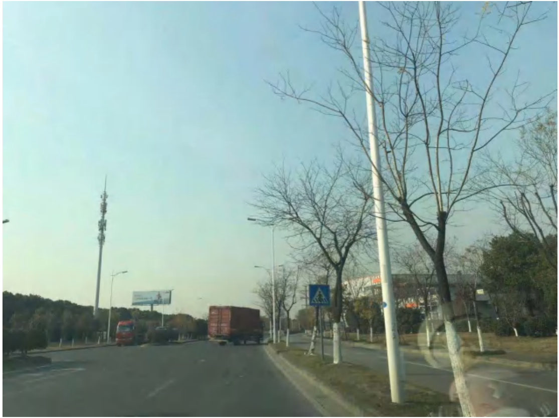
17. 锡梅路给水管道回填及道理修复
