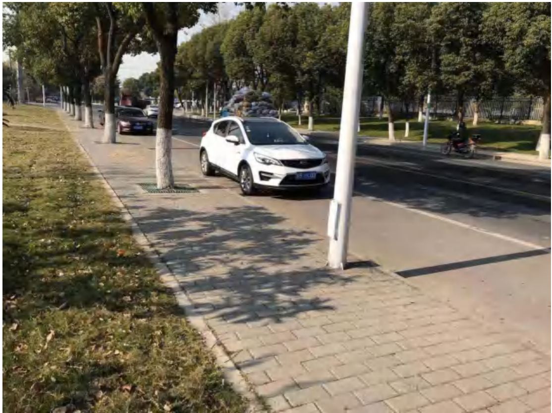
5. 锡协路给水管道回填及道理修复
