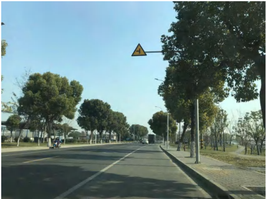
6. 锡协路给水管道回填及道理修复
