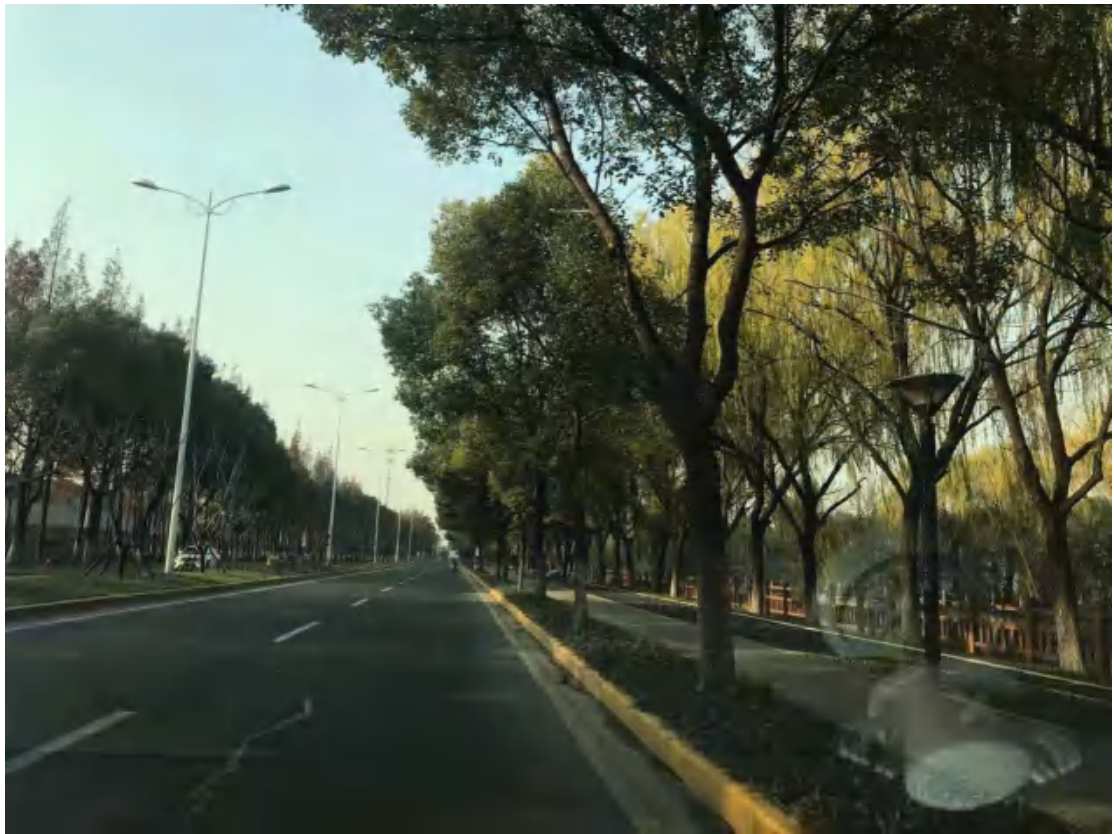
21. 锡兴路给水管道回填及道理修复
