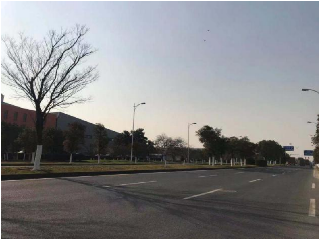
12. 锡梅路给水管道回填及道理修复
