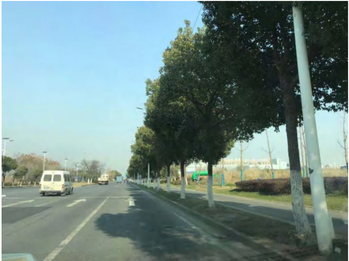
8. 新鸿路给水管道回填及道理修复
