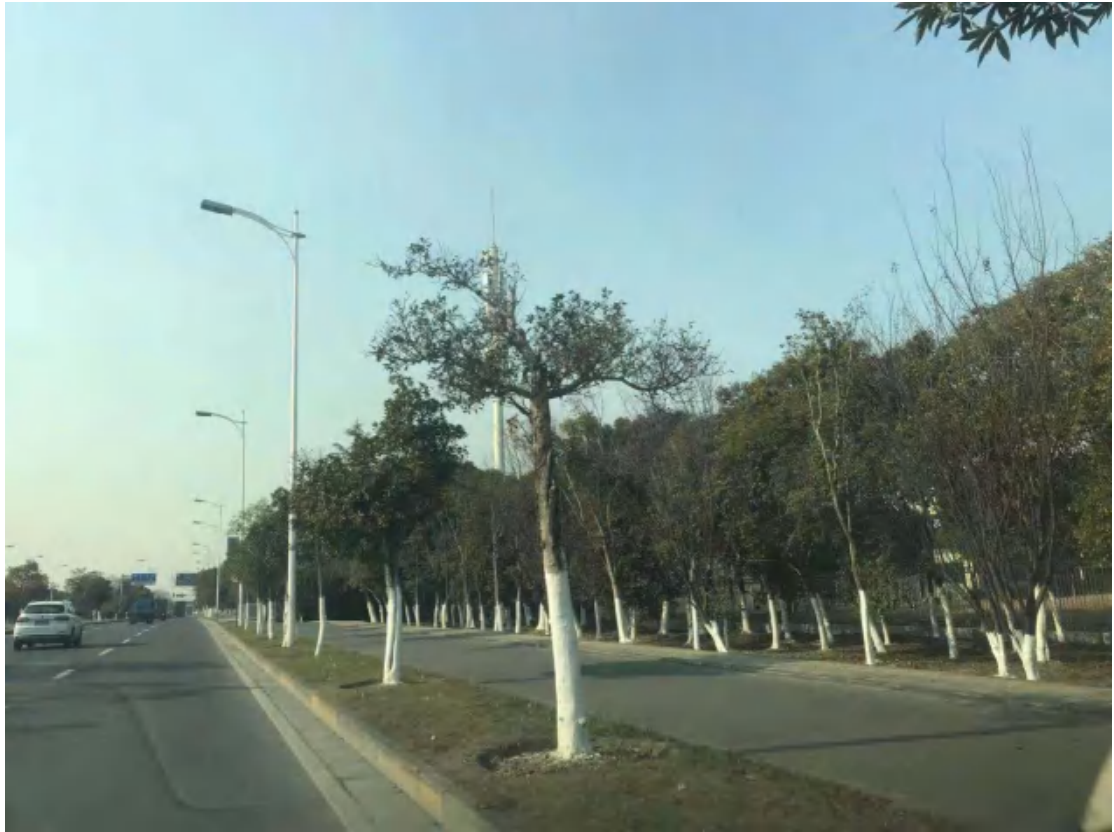
15. 锡梅路给水管道回填及道理修复
