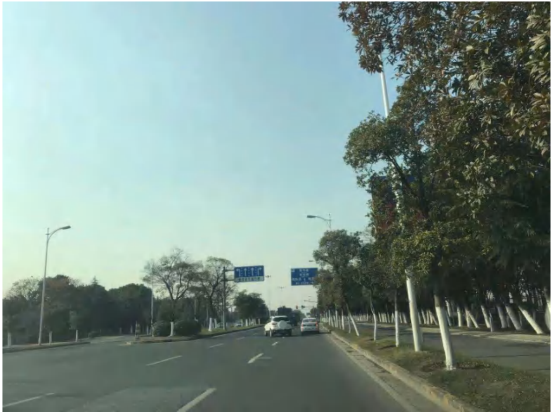
10. 锡梅路给水管道回填及道理修复
